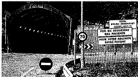
Las señales anunciaban la prohibición de atravesar el túnel. M. PARDINA
