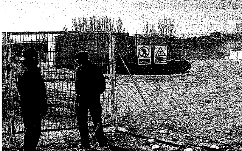
El alcalde de El Grado (izquierda) y el alguacil en la depuradora, inacabada y sin fecha. JOSÉ LUIS PANO
