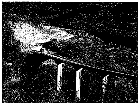
El viaducto de Fanlillo es una de las infraestructuras del trazado. R.G.
